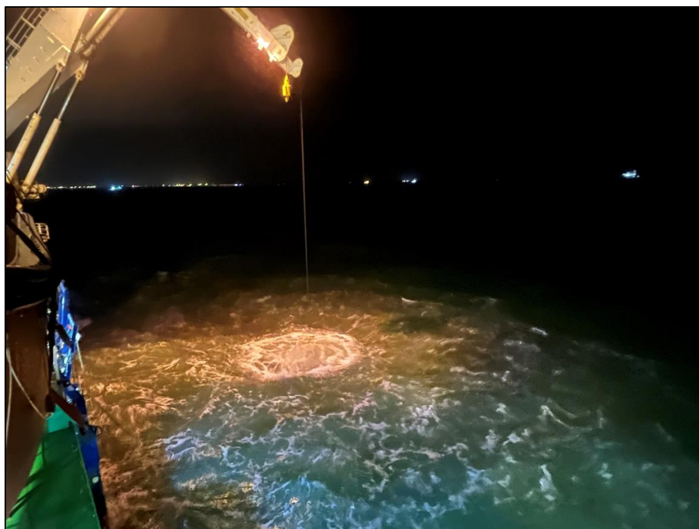
Figura 8. Scavo subacqueo in corso.
