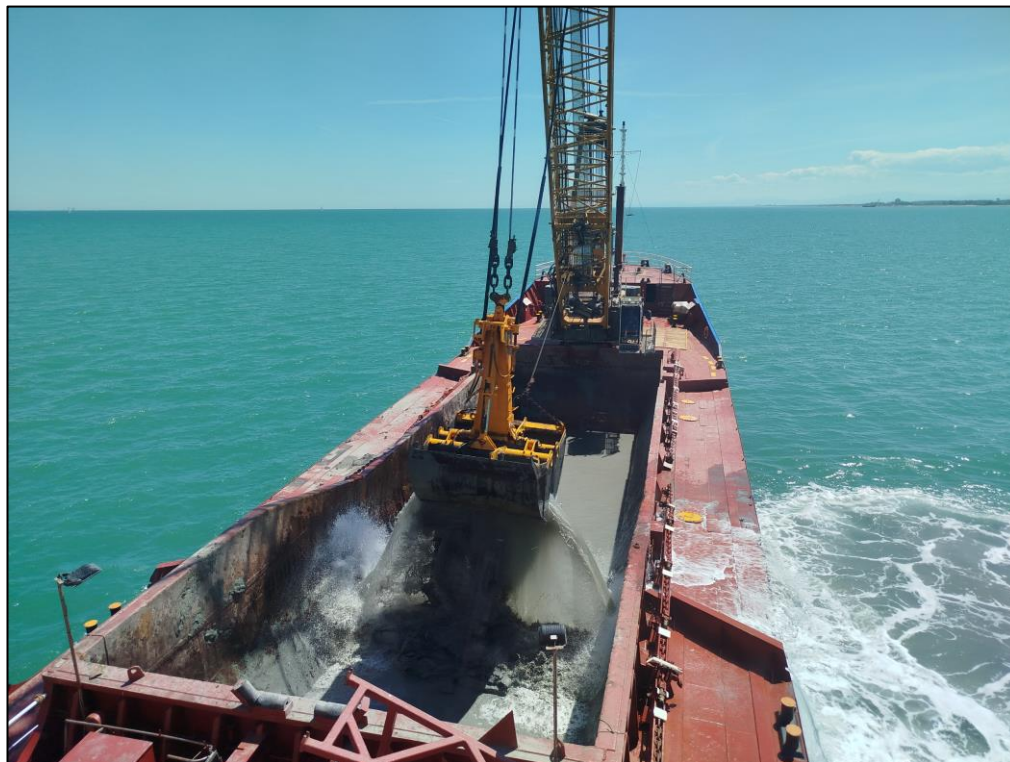
Figura 18. Il carico tramite benna bivalve.
